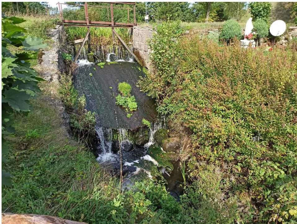
Fot. 32. Nieużytkowany jaz po dawnym młynie.
