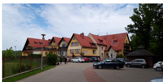
Fot.11 Obiekt „Rehabilitacja Wieżyca” (AN 06.2020)
