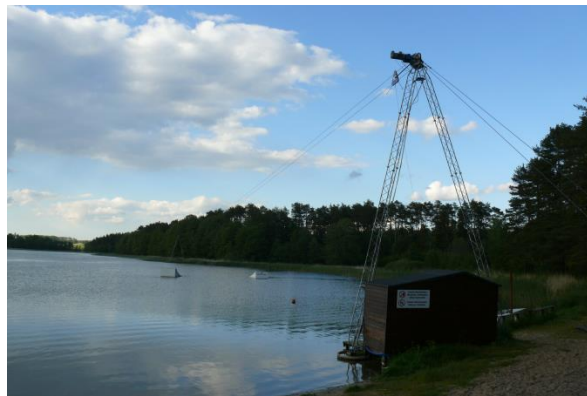
Fot.34 Wyciąg do wakeboardingu (AN 06.2020)
