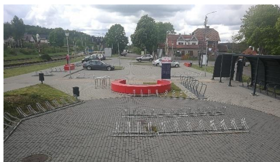
Fot.55 Węzeł integracyjny Gołubie (BJS. 05.2020)
