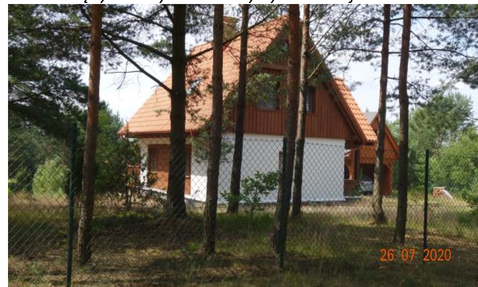
Budynek mieszkalny o prostej formie i poprawnych proporcjach, wykończony na wzór architektury regionalnej regionu.
