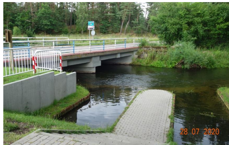
Zagospodarowane wyjście na brzeg z miejscem postojowym.
