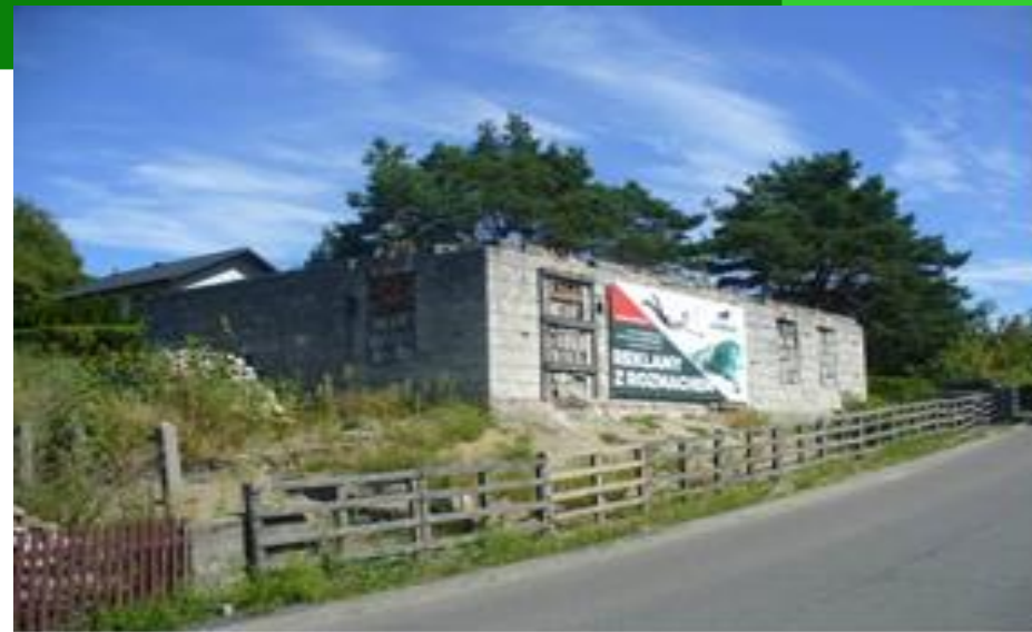
Ruina niedokończonego budynku wyeksponowanego w strukturze miejscowości Wdzydze
