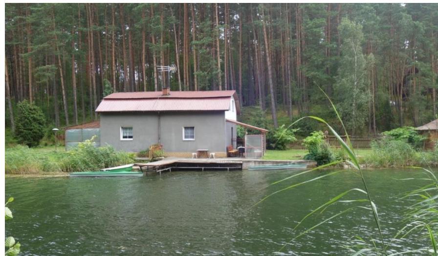
Sytuowanie zabudowy za blisko linii brzegu jeziora.
